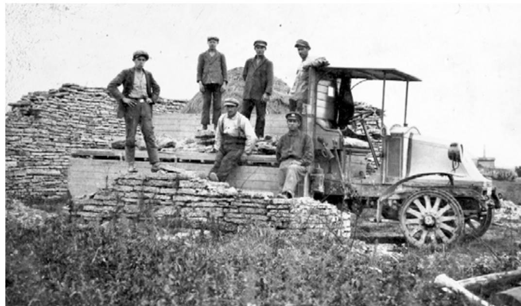
Jõelähtme silla ehitus, foto Vandjala külast Saare talust 1.
